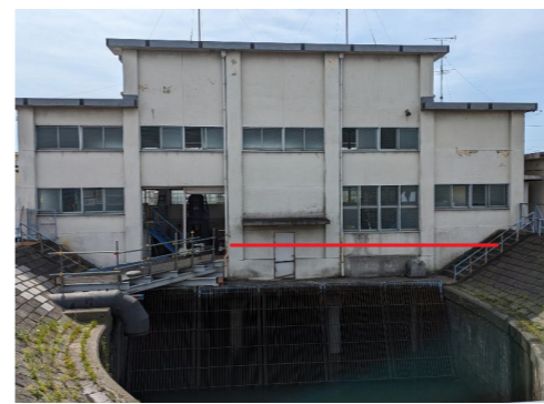
浸水した桑原揚水機場 当日は、赤線の部分まで水に浸かった
