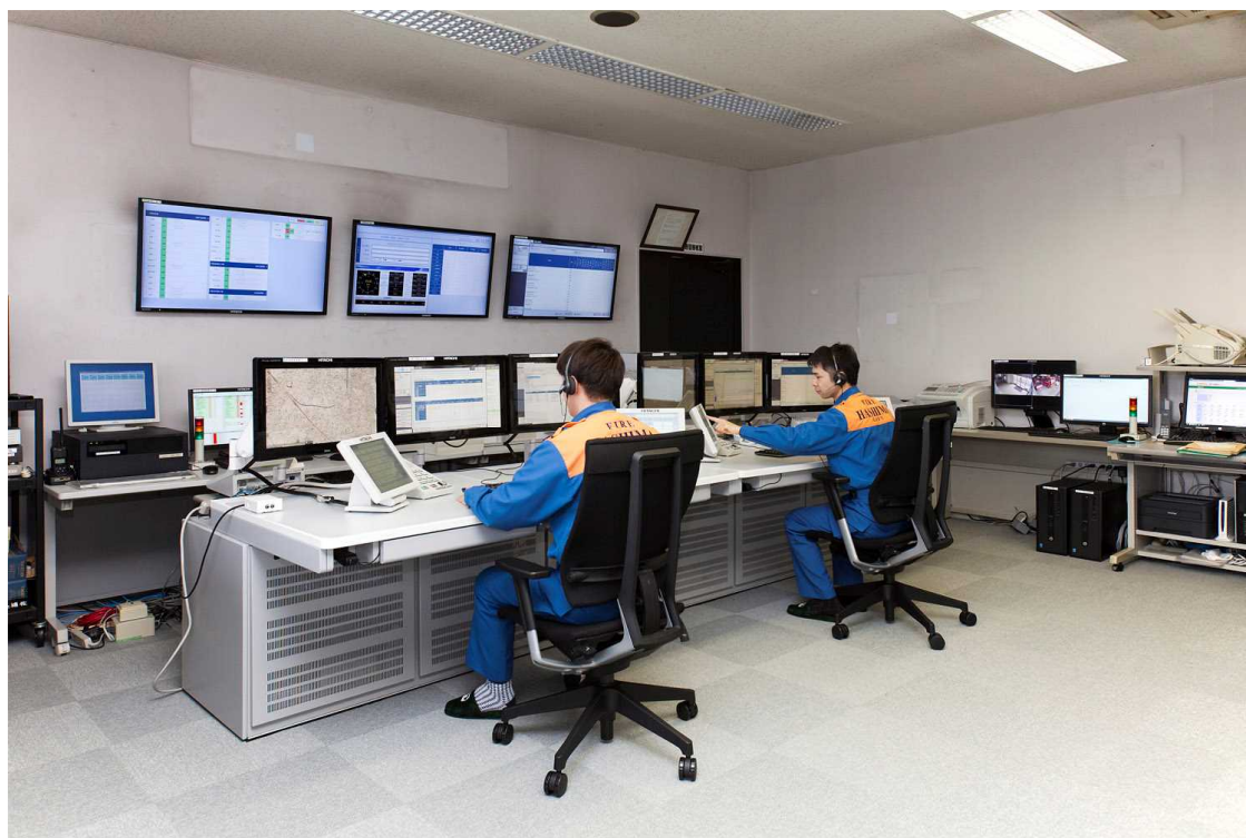
高機能消防指令システム
