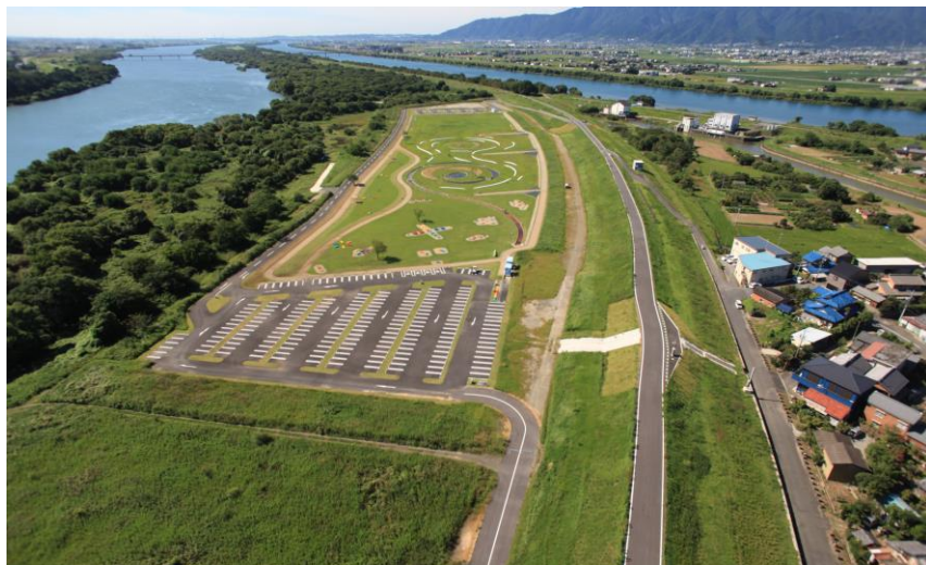
国営木曾三川公園桜堤サブセンター
