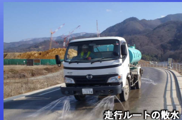
走行ルートの散水
